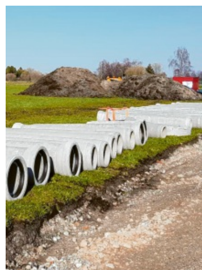
Kanalrohre warten auf ihre Verlegung im neuen Wohnbaugebiet „W12 - Hungerbach-Nord“. Foto: Gemeinde
